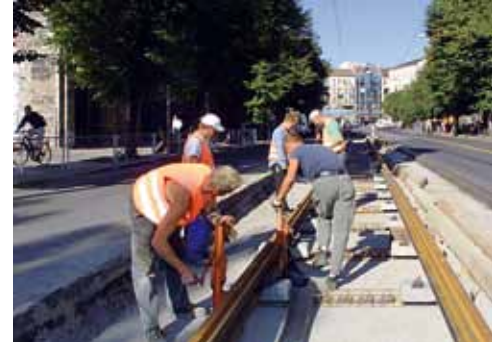
Instalarea protecției elastice șină – flanșă
