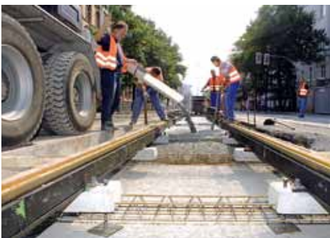
Betonarea panoului de cale
