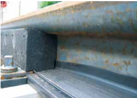
Instalarea elementelor laterale ale șinei
