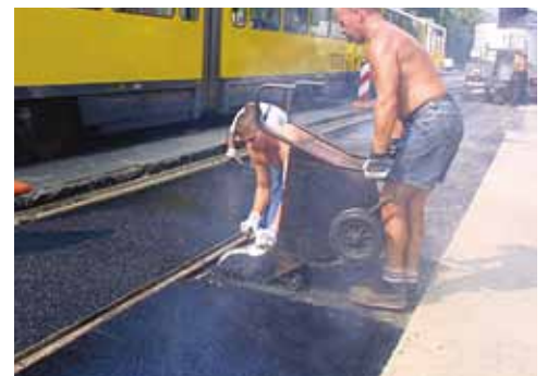
Instalarea stratului superior: de ex. asfalt
