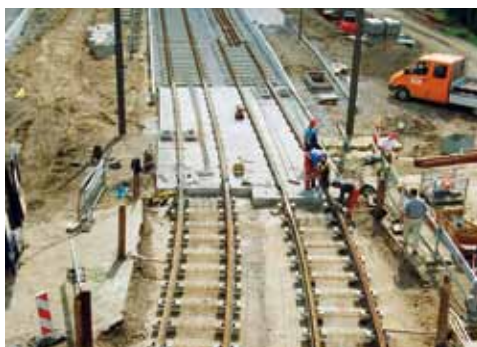
Trecerea de la RHEDA CITY la secțiuni cu balast
