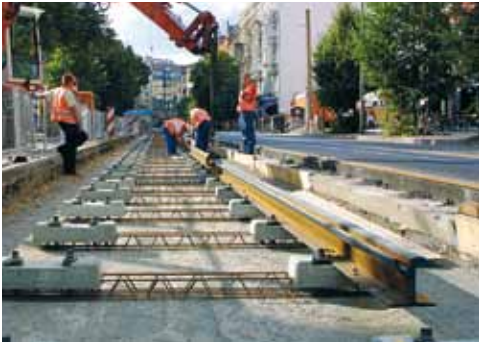
Pozarea șinelor urmată de sudură
