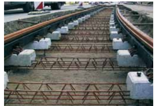
Instalarea finală și fixarea panoului de cale
